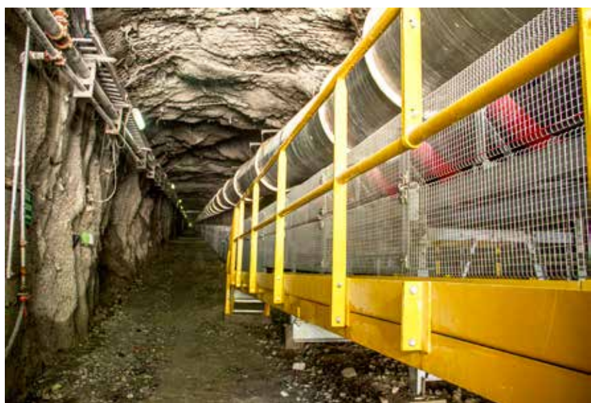
PROYECTO QUINDE: Túnel para la transportación segura de caliza.
