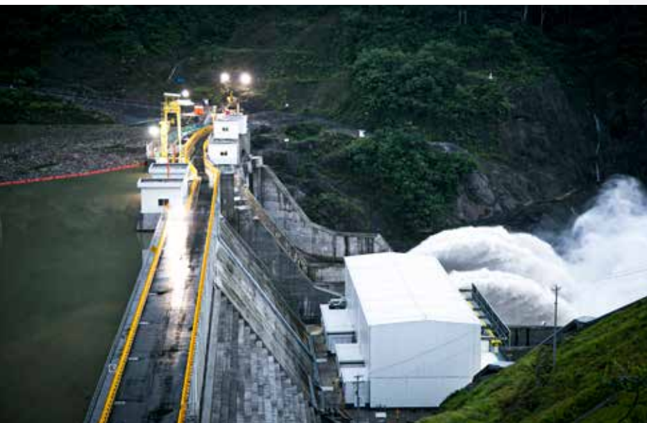
FOTO: Ministerio de Electricidad y Energía Renovable
