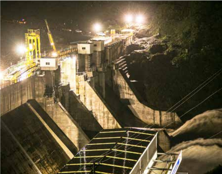
FOTO: Ministerio de Electricidad y Energía Renovable
